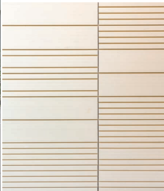
Detailaufnahme der Fassade
