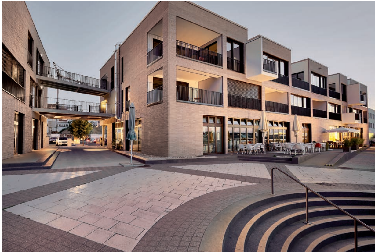
Für die Außenwände des Gebäudes wurden die 510 Millimeter langen Wasserstrich-Ziegel Polaris von Wienerberger verwendet.
